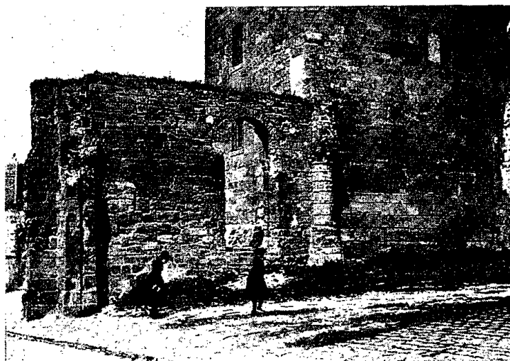
Fig. 6. — EXTRÉMITÉ OCCIDENTALE DE L'ÉGLISE DE BOISSY-L'AILLERIE (vue intérieure avant la démolition partielle).
